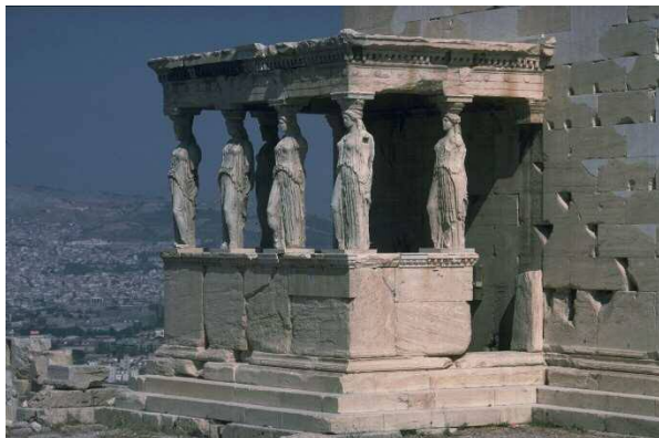
Erecteion — Pórtico de Cariátides, Atenas, 1993 © j.m.russo
